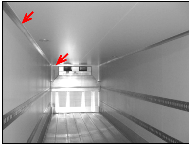
Gesamtansicht innen (Verklebung)
